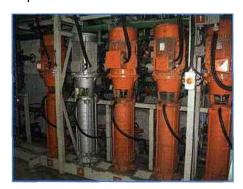
Les pompes à incendie sont une autre application principale de pompage qu'on retrouve dans ces installations : certaines d'entre elles sont entrainées par moteur électrique, d'autres par moteur diesel afin de subvenir à tout besoin
